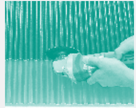
ขัดปลายแผ่นด้วยกระดาษทราย ละเอียด แผ่นจะไม่เกิดน้ำซัง
